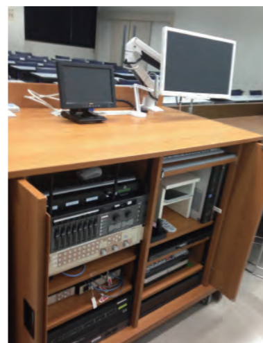
必要な情報通信機器を1つに集約したコンパクトなIT教卓システム
