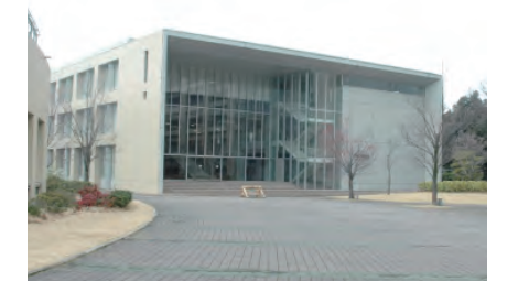
Cboxを設置した大講義室がある総合教育研究棟フロネシス
